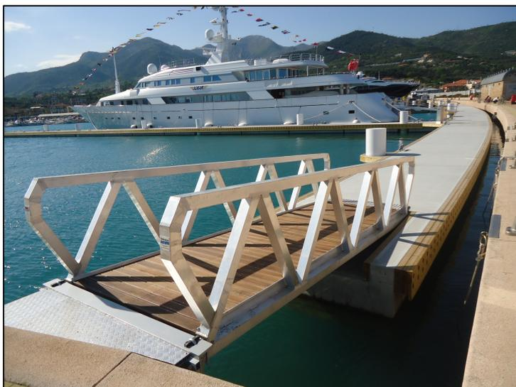
La línea principal de pantalanés flotantes de hormigón fue diseñada especialmente para seguir la misma curva del muelle existente.
